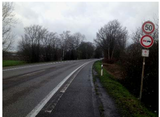
Fahrbahn schmaler durch neue Markierung
