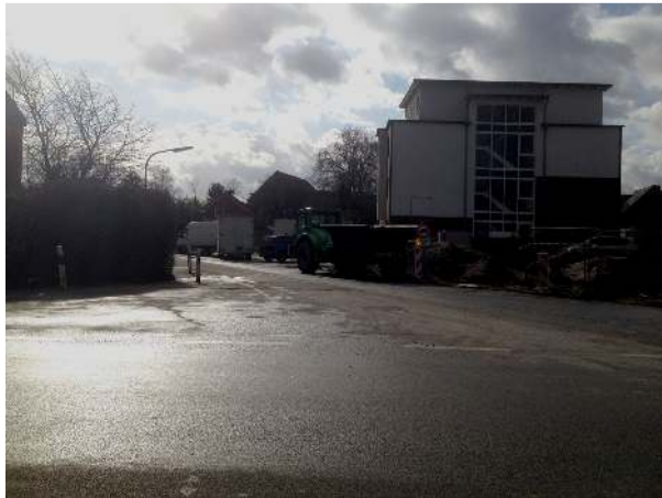
Kreuzung Dorfheide/Hackfurthstraße mit Baufahrzeugen
