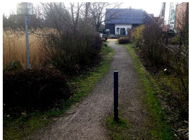
Geh- und Radweg im Neubaubereich Schultenkamp (Hackfurthstraße)
